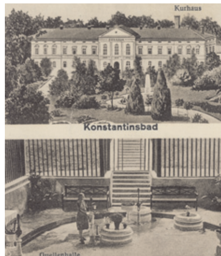
Foto Curhausu a pitného pavilonu se samostatně vyvedenými prameny v "noučích" lázních Nová Ves
